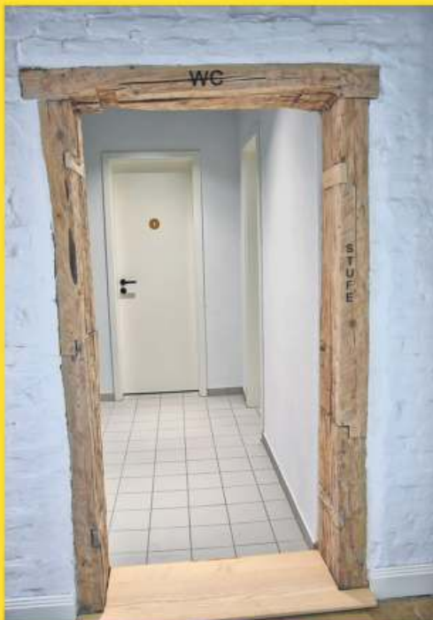
Historische Türrahmen im Erdgeschoss freigelegt
