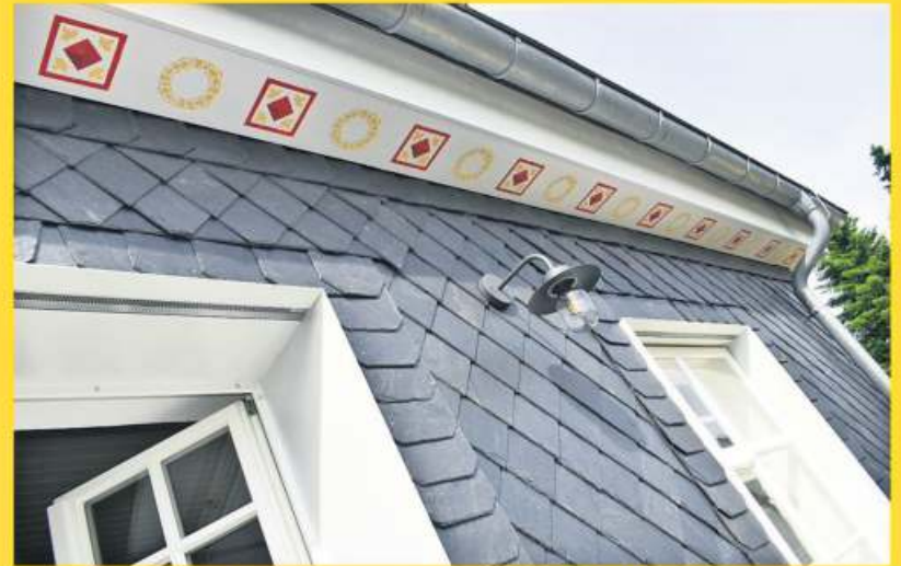
Vorgefundene Ornamente am Dachvorsprung neu angebracht
