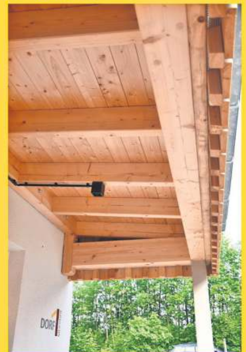
Neue Überdachung im Eingangsbereich mit Logo
