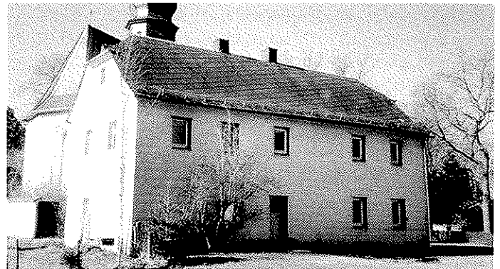
Das im April 2000 abgerissene Mesnerhaus in Issigau, Kirchplatz 10
