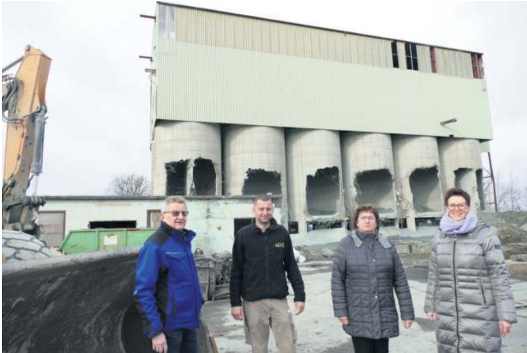
Hier steht die Anlage noch. Im Bild (von links) Wieland Spörl, Walter Spörl, Sieglinde Spörl und Bürgermeisterin Patricia Rubner
