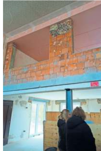
Der Blick auf die neuen großen Fenster Türen und einen Teil der Galerie im Obergeschoss.
