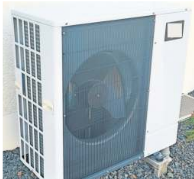
Eine Luft-Wärmepumpe ist klein und damit beliebig am Haus installierbar. Foto: Leonhard Crasser
