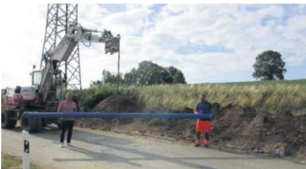
Das Bild zeigt Sascha Eberhardt vom Stadtbauamt und Jürgen Hohberger vom Wasserwerk
