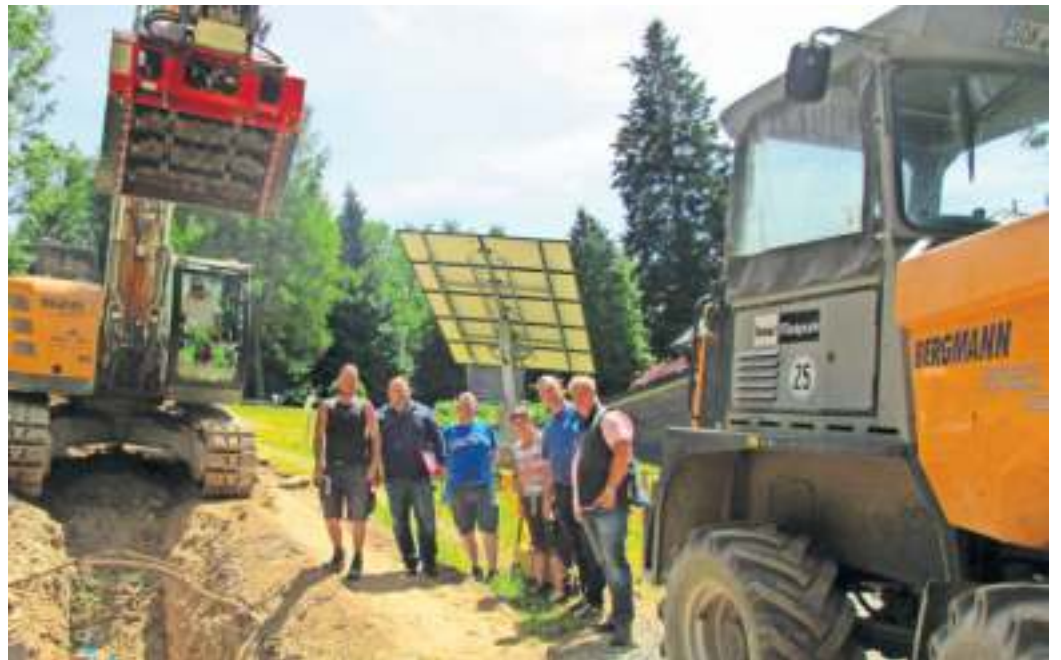
Das Foto zeigt von links: Herrn Nitzsche (Polier, Firma Schwall & Mayer), Thomas Walther (Bauamt, Stadt Naila), Lars Bubner (Bauleiter, Firma Schwall & Mayer), Andrea Ständner (Grundstückseigentümerin), Klaus Gädtke (Wassermeister, Stadt Naila), Frank Lailach (Bauleiter USS-Consult GmbH)
