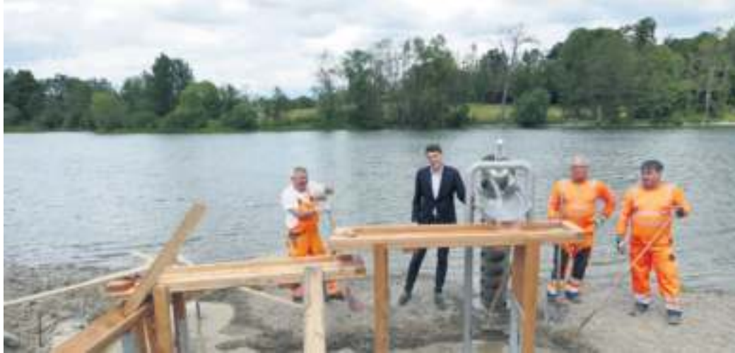
Unser Bild zeigt die Betonierarbeiten zum Wasserspielgerät (von links) Bauhofmitarbeiter Thomas Brunner, Bürgermeister Kristan von Waldenfels, Bauhofmitarbeiter Slavko Zidar und Christoph Gramalla.
