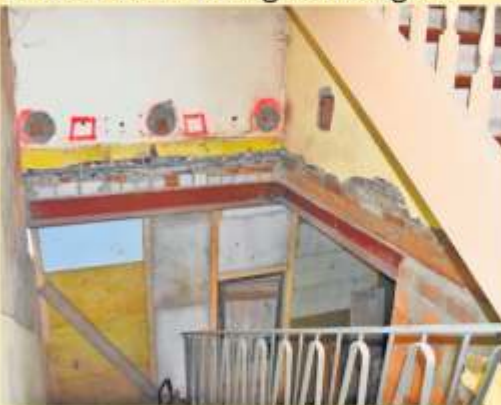
Einbau von Abfangstahlträgern
