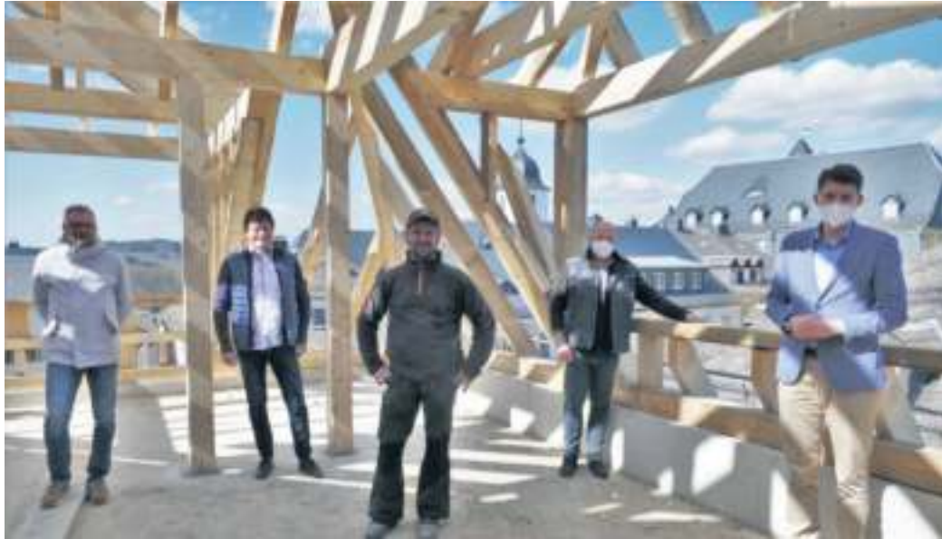
Das Foto zeigt über den Dächern der Stadt Lichtenberg (von links) Architekt Christian Dreßel, Bauherr Martin Süß, Sven Sonntag von der gleichnamigen Zimmerei aus Zell, Hans Schneider vom gleichnamigen Bauunternehmen aus Sparneck und Bürgermeister Kristan von Waldenfels.
