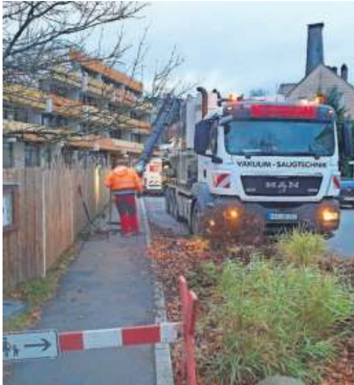
Das Foto zeigt Mitarbeiter der Firma Berndt beim Absaugen des Materials.
