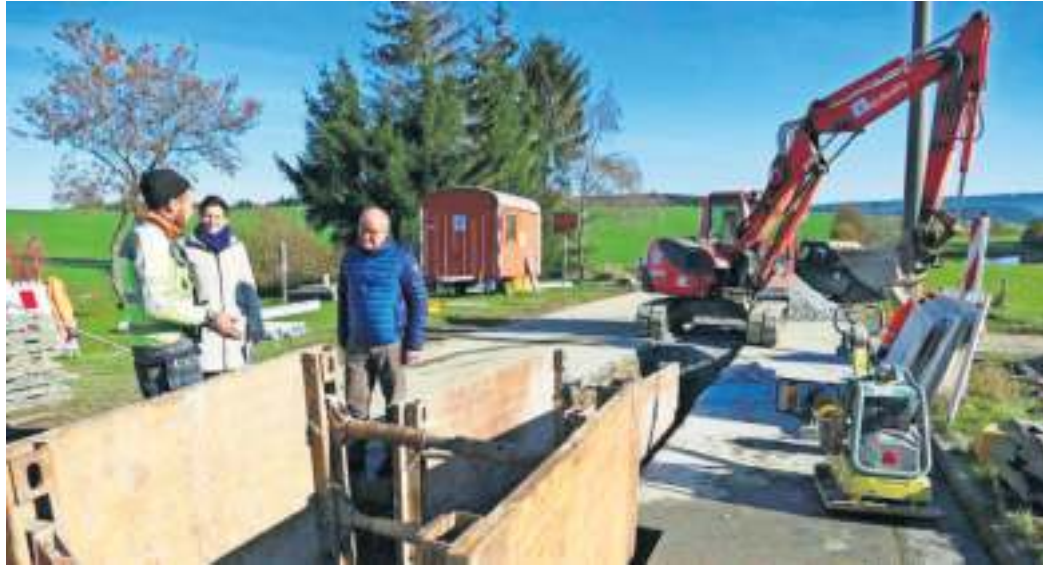
Polier Woldemar Buchmüller von der Firma Tief- und Ingenieurbau GmbH Weischlitz (TIW) erläutert die Baumaßnahmen für die Kanalsanierung in Schnarchenreuth. Mit im Bild Bürgermeisterin Patricia Rubner und Landtagsabgeordneter Alexander König.
