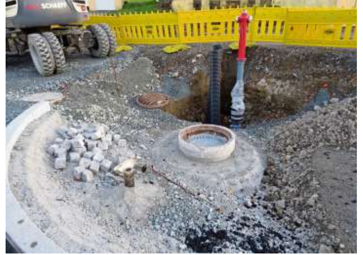
Neuer Hydrant auf neuer Wasserleitung
