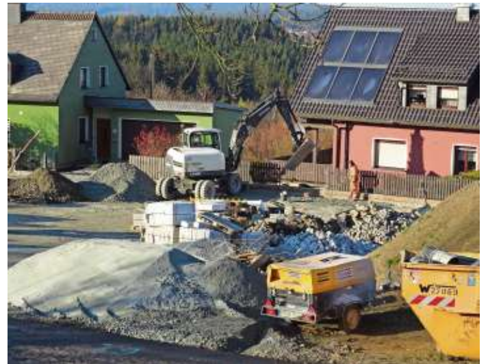
Ausbau der Ortsstraße
