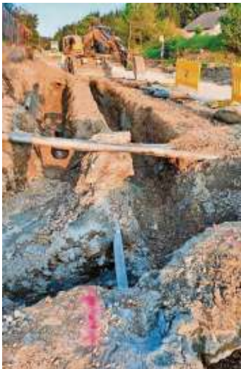
Tiefbau für Wasserleitungserneuerung
