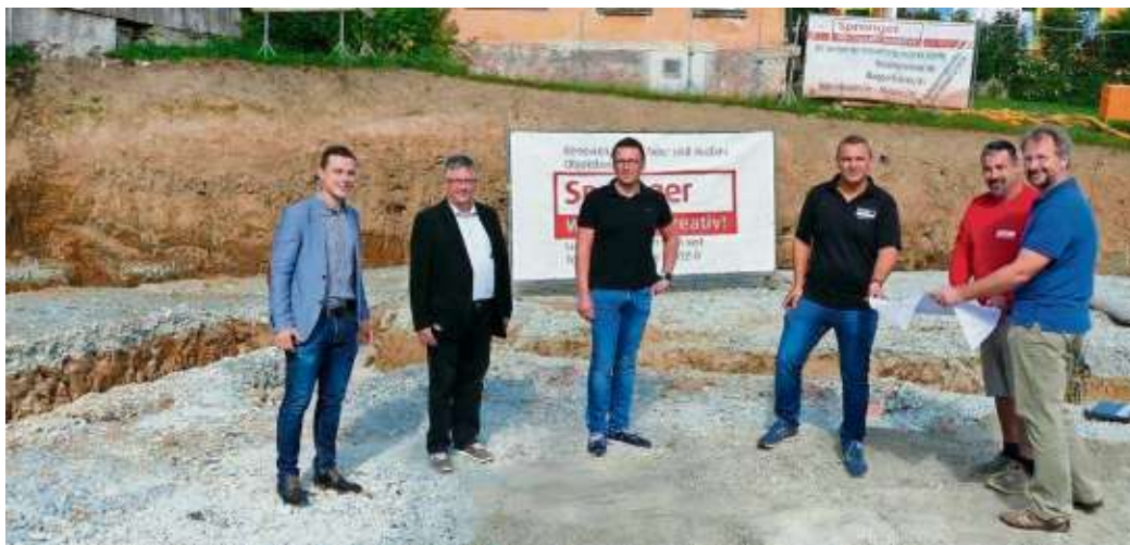
Bei einer Baubesprechung informierten sich über den Sachstand. Das Foto zeigt (von links) dritten Bürgermeister Maximilian Stöckl, zweiten Bürgermeister Wolfgang Gärtner, Bauamtsleiter Heiko Josiger, Bauleiter der Firma Sprenger Jörg Schnabel und der Polier Andreas Fränkel sowie der Architekt Markus Schiffel.
