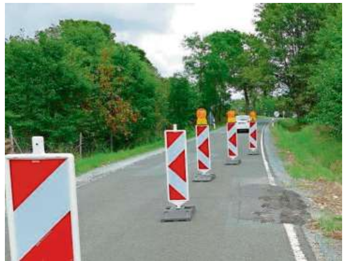
Das Foto zeigt die Vertiefung (Pinge) der Staatsstraße, die durch frühere Bergbauarbeiten entstanden ist.
