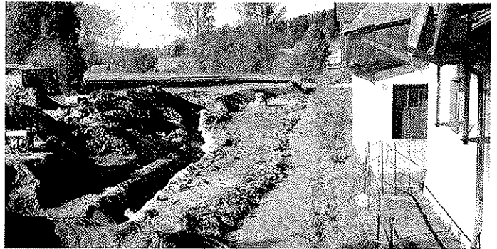
Aufgrund des großen Erdabtrags im Zuge der Baumaßnahme zum Hochwasserschutz im Dorfbereich musste die Zuleitung zum Brunnen am Pültzenberg (bekannt auch als "Stollen") tiefer gelegt werden
