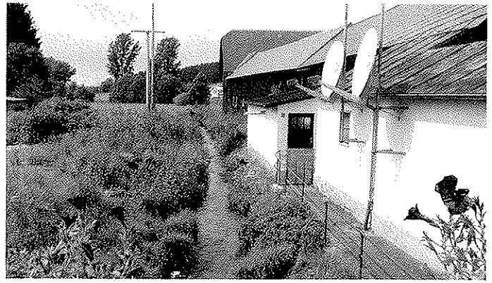
So sah es vor Beginn der umfangreichen Bauarbeiten mit Blick in den Issiggrund Richtung Neuenmühle aus
