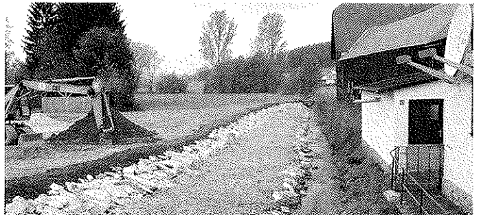
So sieht es jetzt nach der Fertigstellung der Baumaßnahme aus. Den Abschluss am Hochwasserbett bildet die Aussaat von Grassamen, die nächstes Jahr das Grau in saftiges Grün verwandeln soll und gleichzeitig eine Befestigung ergibt, um das Ausschwemmen zu verhindern
