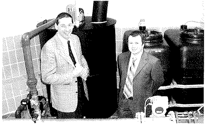
Dr. Andreas Burger von der Firma Hydrotec Rehau mit Bürgermeister Dieter Gemeinhardt vor der neuen Trinkwasseraufbereitungsanlage.
